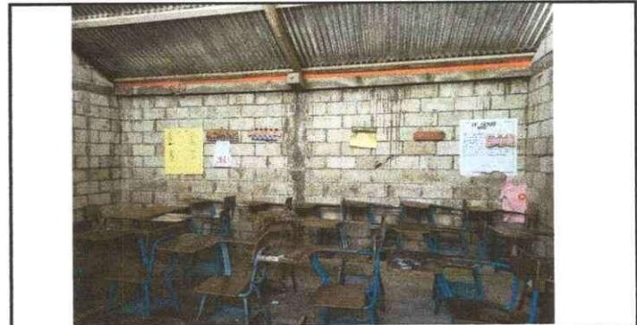
Foto 6: Salón de primero básico falta repellar y los canales no esta en buen estado en la época de lluvia se filtra agua dentro del salon, y falta de pintura.
