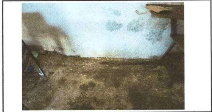
Foto 4: En los salones de primero y tercero básico el piso se encuentra dañado y unas partes ya no cuenta con tortas de cemento.
